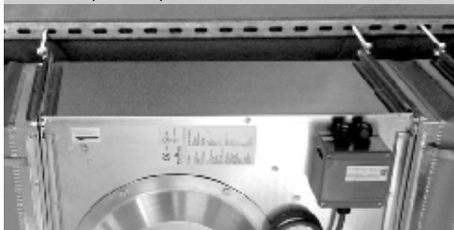
■ При высоком влагосодержании, когда внутри вентилятора может образовываться конденсат (душевые, кухни, прачечные), рекомендуется устанавливать вентилятор миской вверх!
