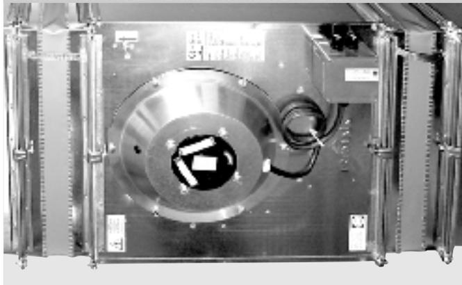
изоляция кабелей, свободно ли вращаются роторные части вентилятора. Минимальный зазор между вращающимися и жестко закрепленными деталями вентилятора не должна превышать **4 mm**.
