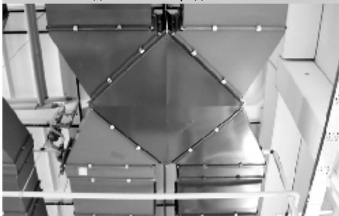
Для отвода конденсата служит PVC выпуск, прикрепленный в самой низкой точке на крышке, которая служит в качестве сборной ванны (при монтаже рекуператоров HRV крышкой вверх) – см. рис. 9, 11.
