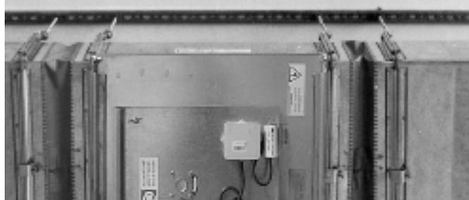
■ Вентиляторы RO могут работать в любом положении. При размещении под потолком, для доступа к клеммной коробке и мотору желательно устанавливать вентилятор откидной крышкой мотора вниз.
